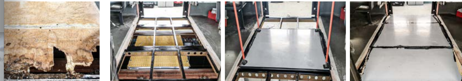
vollständige Fußbodensanierung: Vom Beschädigten Holzfußboden zum System aus GFR-Sandwichplatten
