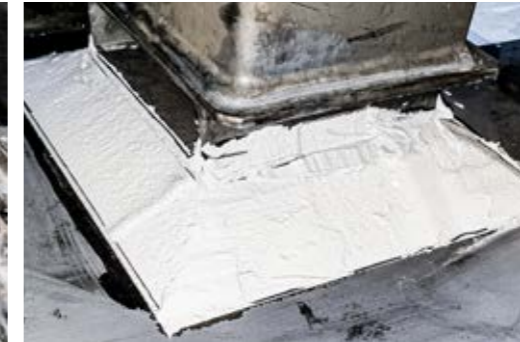
Versiegelung von beschädigten Dichtfugen
